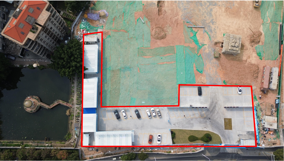
已布设的施工生产生活区
