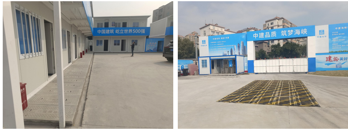
已布设的临时排水沟、洗车台
