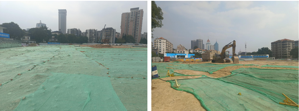
已采取的临时苫盖措施
