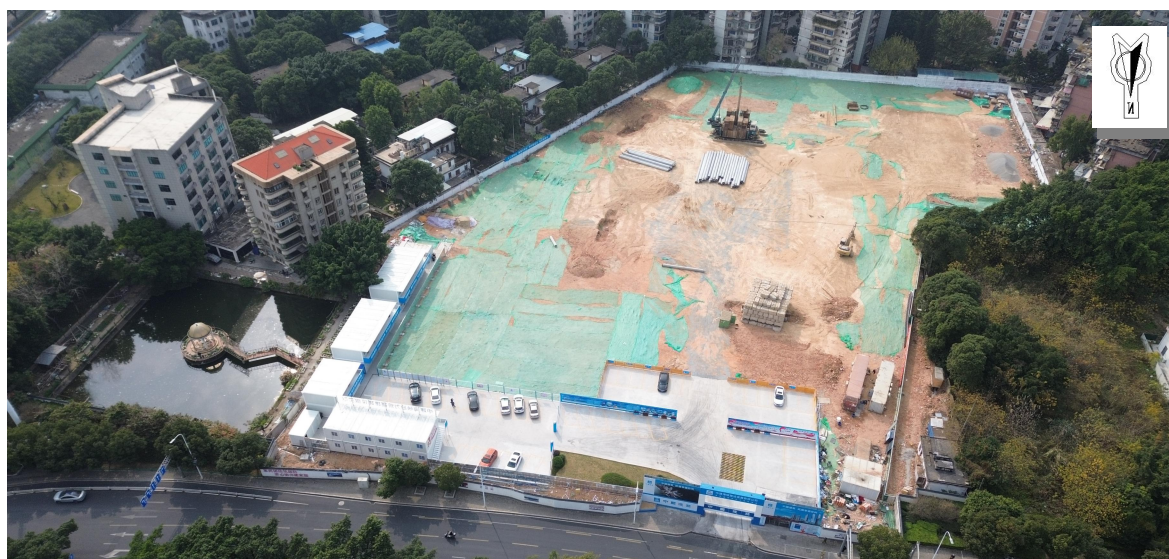
项目航拍影像图
